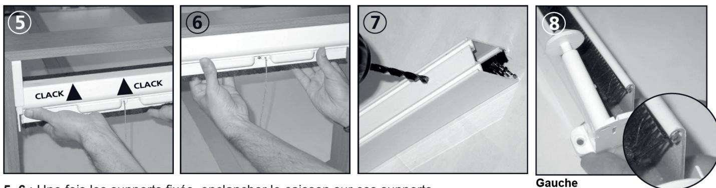
5, 6 : Une fois les supports fixés, enclancher le caisson sur ces supports.
