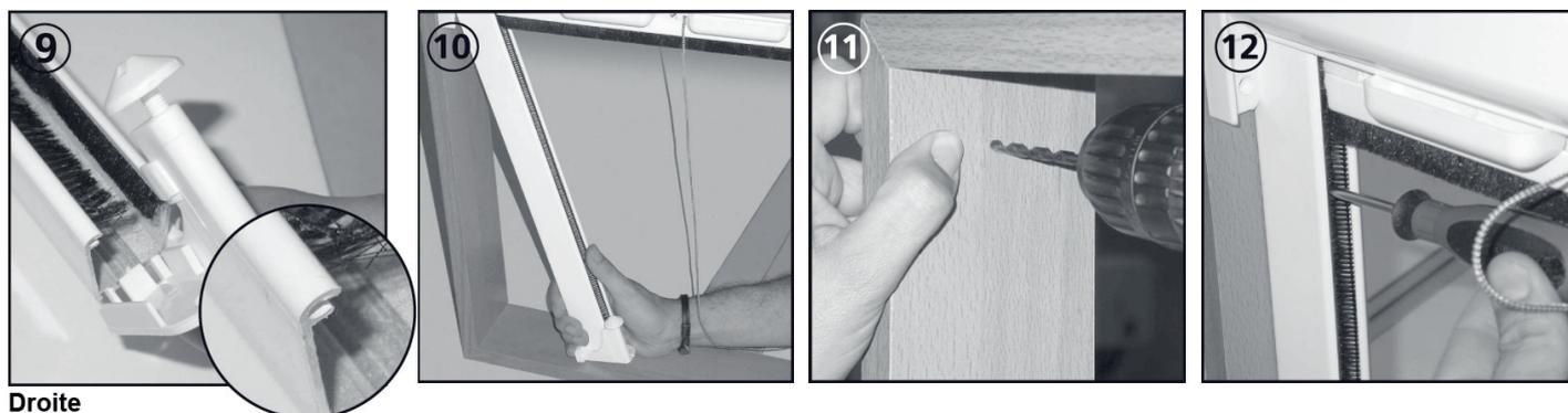
10 : Installer les coulisses dans le montant de la fenêtre en les raccordant au caisson.
